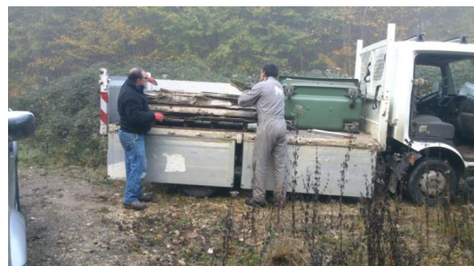
Le Maire et le 1 er adjoint débarrassent l'amiante vers un site spécialisé
